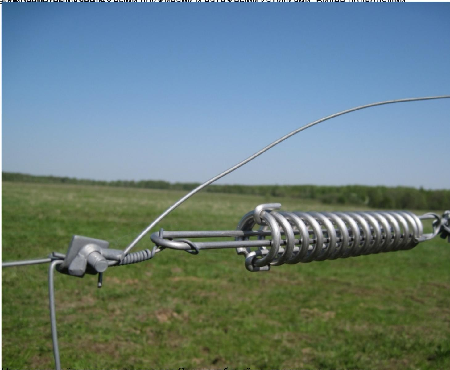
проводящий элемент крупного плана с пружиной для компенсации длины
