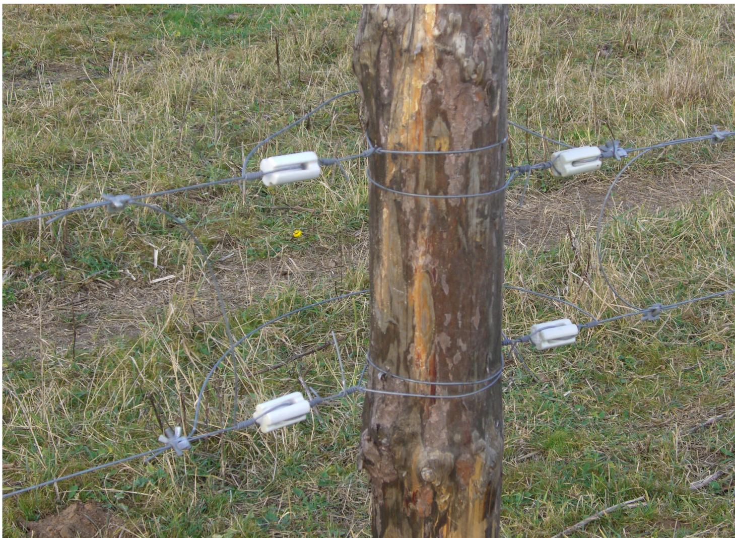
Монтаж линии на опорных изоляторах
