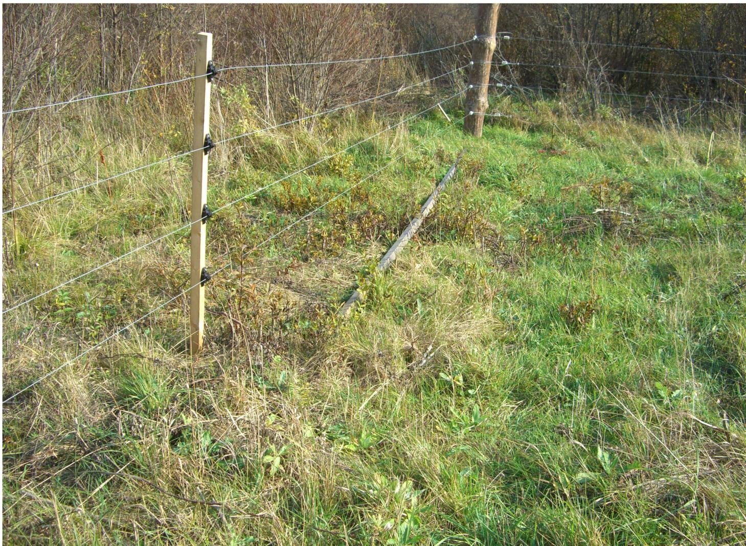
Промежуточные опоры с пластиковыми изоляторами
